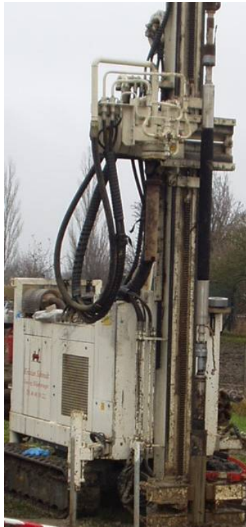
Figur 5.3 Packersystem nedhejses i boring vha. borerig
