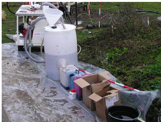
Figur 5.6 Tracere inden opblanding i 200 liter tønde. Pumpen ses i baggrunden.
