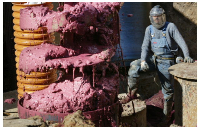
Figuren viser injektion af kaliumpermanganat i storskala borer. Tak til Tom Heron, Niras for lån af foto.
