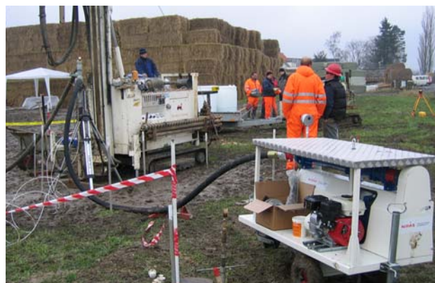
Pneumatisk frakturering i Vadsby, Hedehusene.
